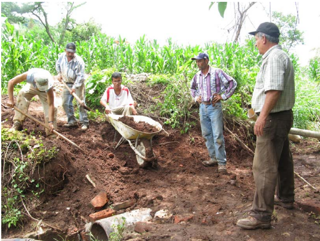
Trabajo comunitario de huerteros regantes de Atotonilco para reconstruir una de las acequias utilizando tubería. Estas actividades, como parte de la organización requerida, contribuyen a la permanencia del sistema agrícola de este pueblo huertero. JJHL, 2010.
