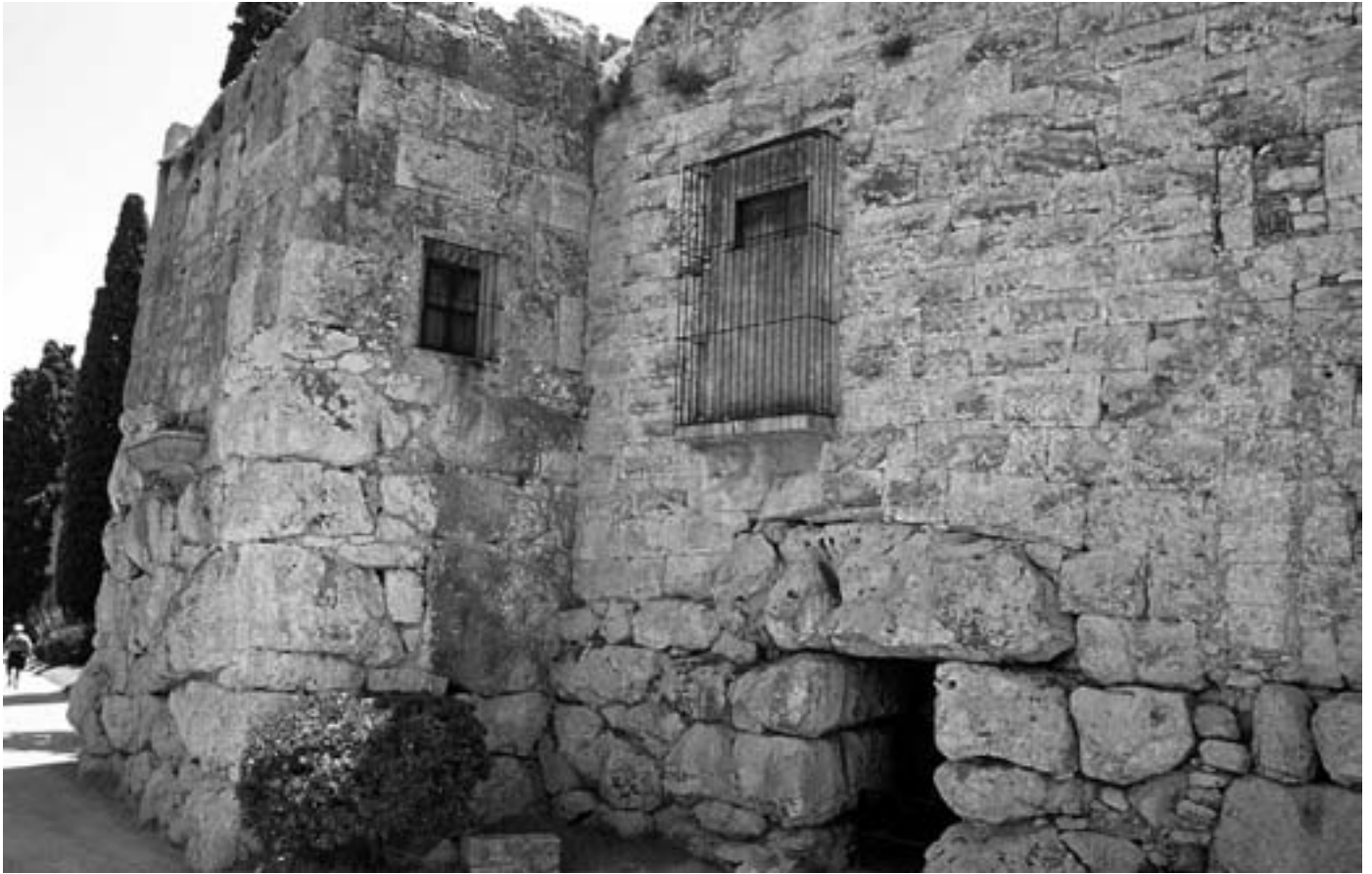
Fig. 28: Vista de la Torre de Cabiscol mostrando igualmente un muro adosado de la segunda fase de la muralla incluyendo una poterna. Se distingue con claridad la diferente altura de los zócalos megalíticos y el diferente tamaño de los sillares utilizados en los paramentos.
