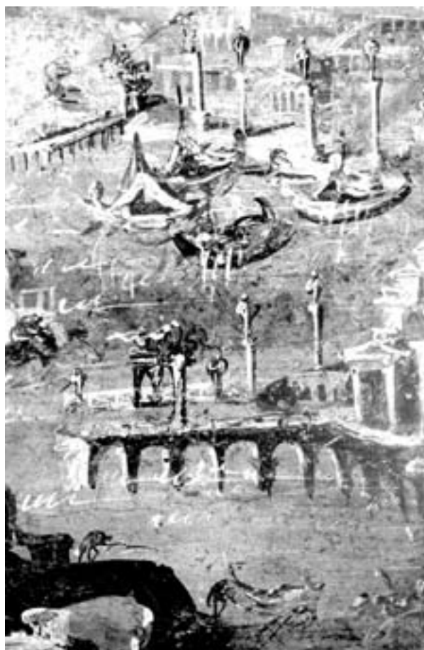
Fig. 116: Pintura mural de Stabies con la representación del puerto de Puteoli y su famoso muelle de pilares ( opus pilarum ).
