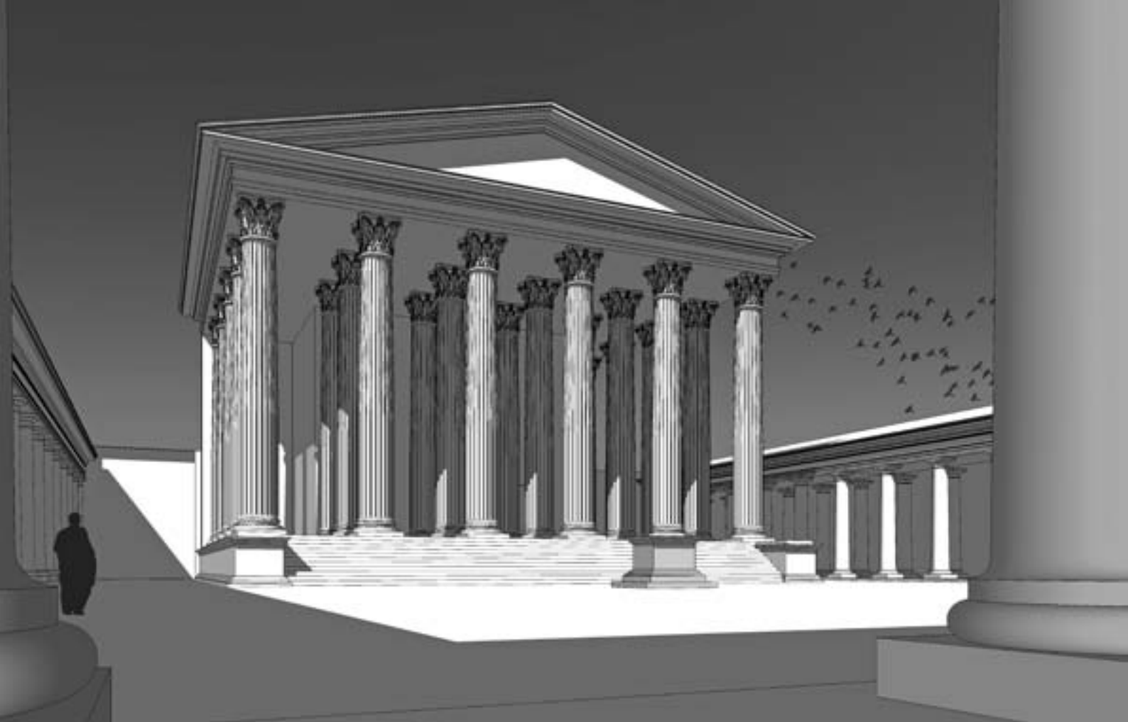
Fig. 106: Reconstrucción de la segunda fase del templo capitolino. Se trataba de un gran templo de sillería levantado sobre un podio con planta periptera sine postico y probablemente con un frente de 6 columnas
