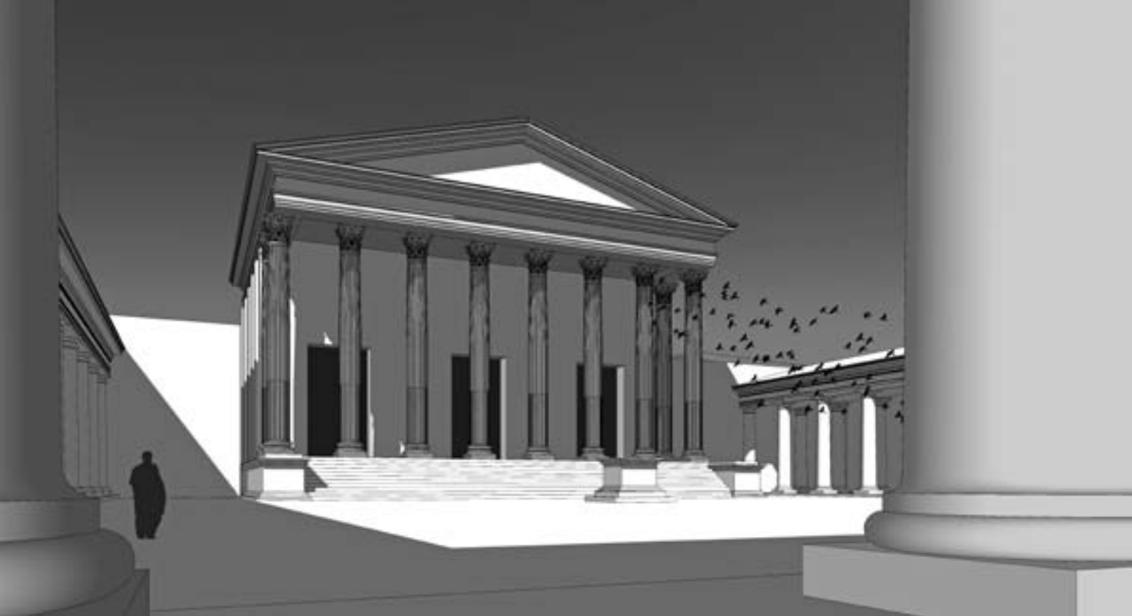
Fig. 110: Reconstrucción volumétrica de la tercera fase del capitolio como un templo octástilo, próstilo y pseudoperíptero.
