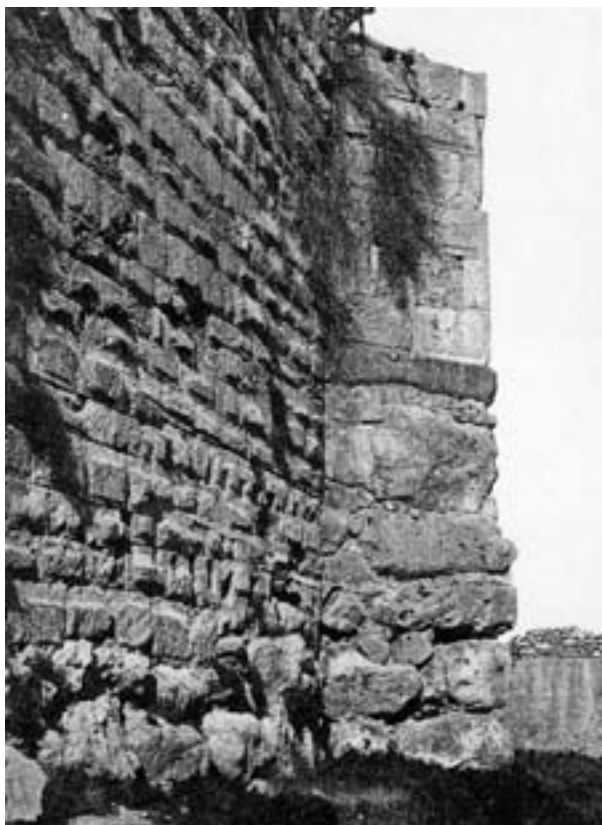
Fig. 16: Detalle de la Torre de Minerva en 1920, entonces denominada de S.Magí. El paramento de la II Fase de la muralla se adosa a la torre dejando libre un ángulo (Foto Ferrer, Dasca, Rovira 1994),
