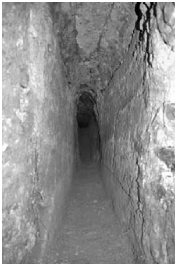
Fig. 118: Galería excavada por M. García y J.M. Macías en el subsuelo de la ciudad romana ( cuniculus ), al sur del área forense para aprovechamiento hidráulico de la red freática y conducción de las aguas hasta el ninfeo del teatro (PAT 2007, ficha 469). Foto J.M. Macías.
