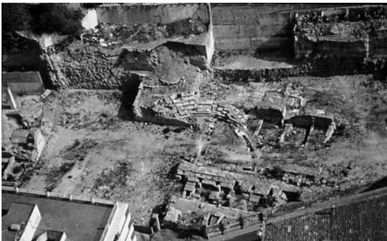
Fig. 162: Vista aérea de los restos del teatro arrasados en los años 1950-1960 por los depósitos de una fábrica de aceites (Foto A. Rifà).
