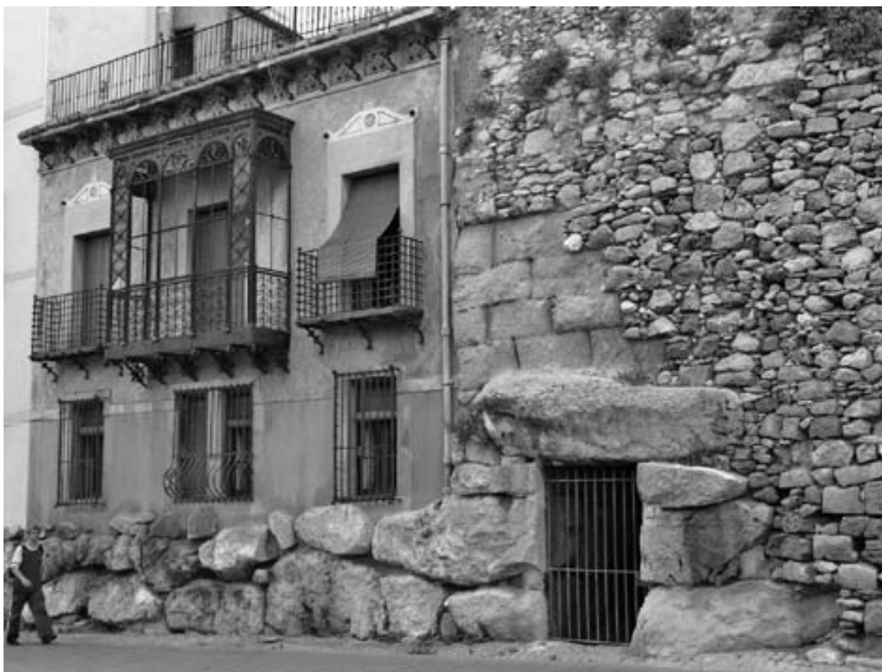
Fig. 52: Vista de uno de los paramentos de la segunda fase de la muralla reutilizado por construcciones de los siglos XVIII y XIX.
