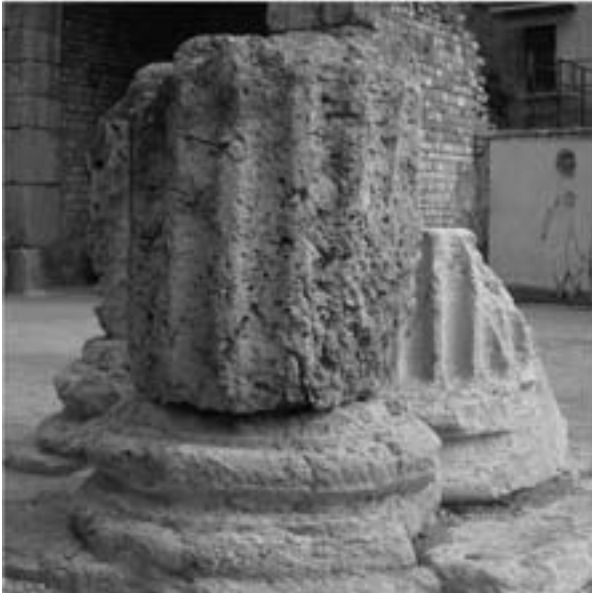
Fig. 144: Basas áticas sin plinto realizadas en piedra local estucada de las columnas de la basílica jurídica (diám. imoscapo: 86 cms).
