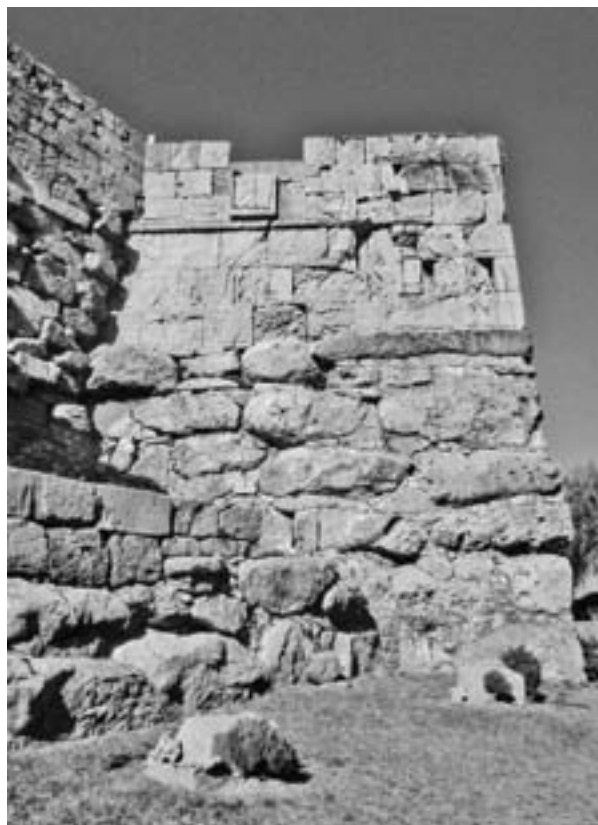
Fig. 17: Vista actual de la Torre de Minerva que muestra el relieve de la diosa aparecido con el derrumbe de 1932 que demostró indiscutiblemente la existencia de dos fases diferentes en la muralla. (Foto Àngel Rifà).
