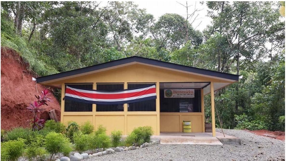
Foto 3. Edificación central, casita de visitantes o de la miel, del proyecto apiturístico Tocorí.
