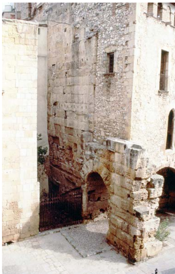
Fig. 110a: Muro de cierre de la plaza de representación visto desde el exterior. Colindante con la bóveda del Pallol y dotado de una puerta de acceso el muro romano se conserva en una altura de 14 m.
