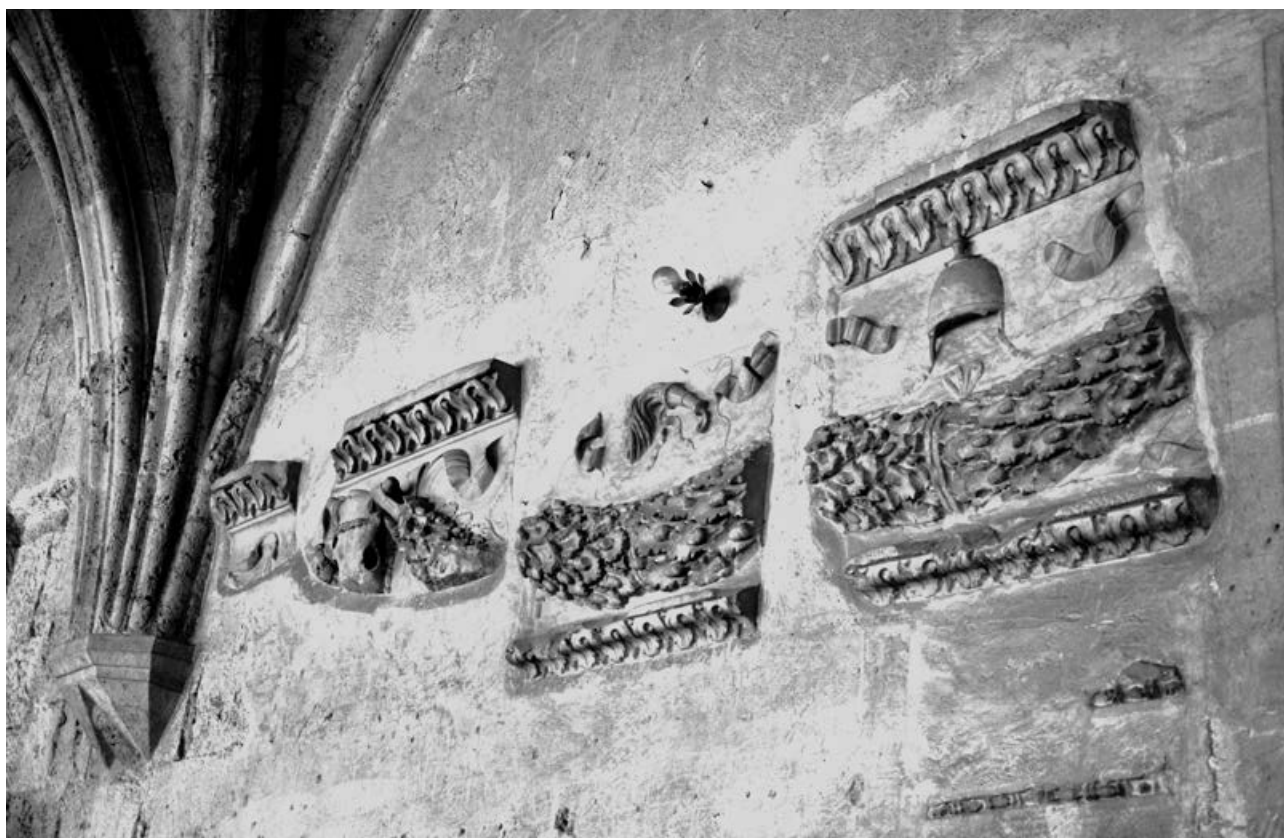
Fig. 40: Al igual que el friso de la figura 39 y otros fragmentos conservados en el MNAT, los bloques arquitectónicos del claustro de la Catedral pertenecieron a un gran edificio sacro construido en época flavia en la Acrópolis de Tarragona. Se encontraron en el siglo XIX en las obras realizadas en la Catedral y fueron colocados en una de las paredes del claustro. El motivo decorativo de los bucráneos (cráneos de buey) unidos por guirnaldas y la presencia de los símbolos sacerdotales sigue el modelo de la decoración del templo dedicado al Divo Vespasiano construido en el foro de Roma.
