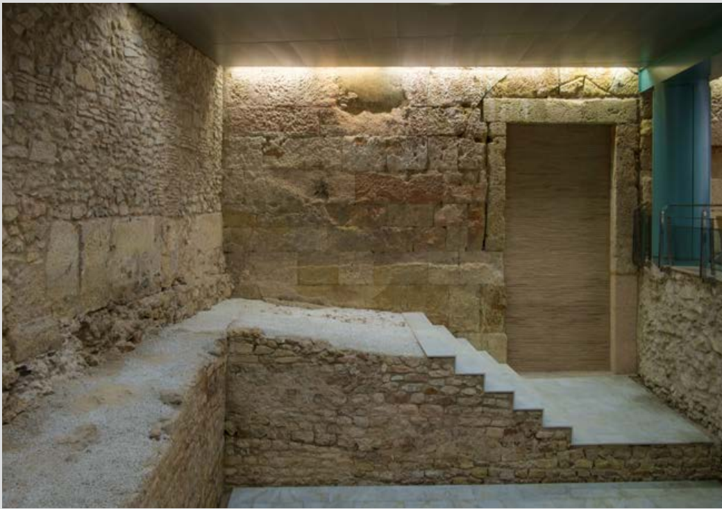
Fig. 109: La torre romana de la Antigua Audiència, simétrica a la Torre del Pretori, ha conservado en su interior el sistema de escaleras que permitían acceder a los diferentes pisos del entorno de la gran plaza. Desde una magnífica puerta situada en la esquina del edificio (abajo derecha), junto al Circo, se accedía a una escalera perfectamente conservada que comunicaba con un segundo espacio (C) que permitía ascender de cota con un sistema de rampa escalonada perimetral (izquierda) hasta alcanzar una última caja de escaleras.
