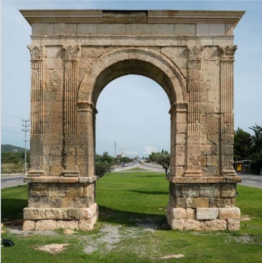
Fig. 23: Izquierda. Vista de la cara norte del Arco de Bará después de la intervención arqueológica de X. Dupré (1991) con proyecto de restauración de J. Costa.
