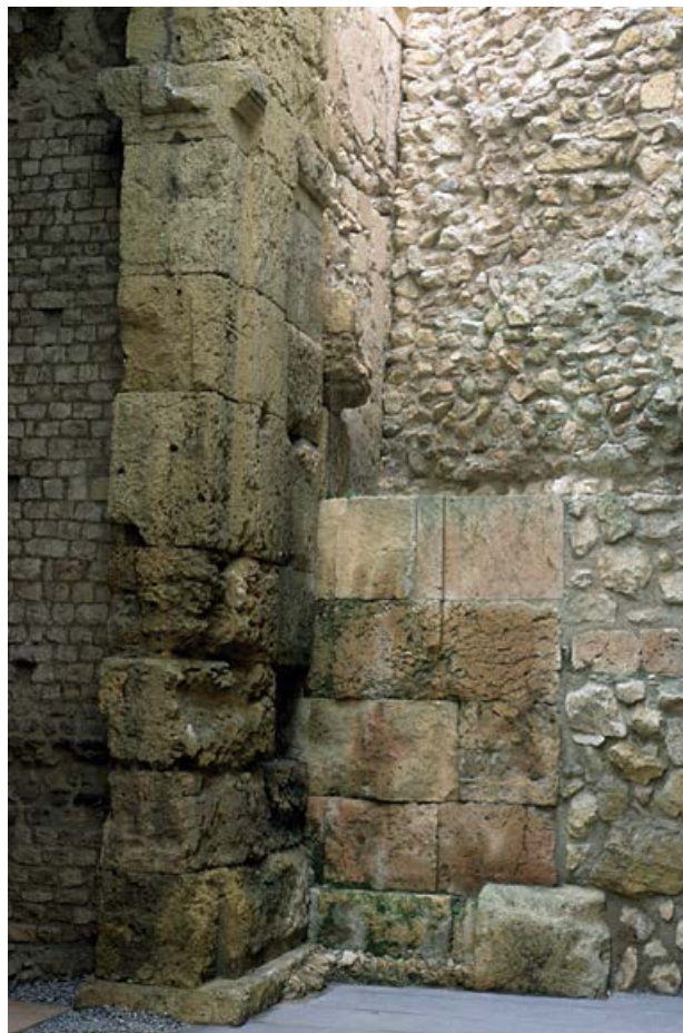
Fig. 125: Vista de la primera pilastra de la fachada del Circo hacia la vía Augusta. A la derecha se aprecia el soporte lateral de una de las puertas de entrada a la ciudad. Incluye una pilastra decorativa.
