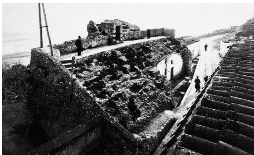
Fig. 138b: Restos del graderío del Anfiteatro a fines del siglo XIX con instalaciones y garita de vigilancia del vecino presidio (foto Archivo Mas).
