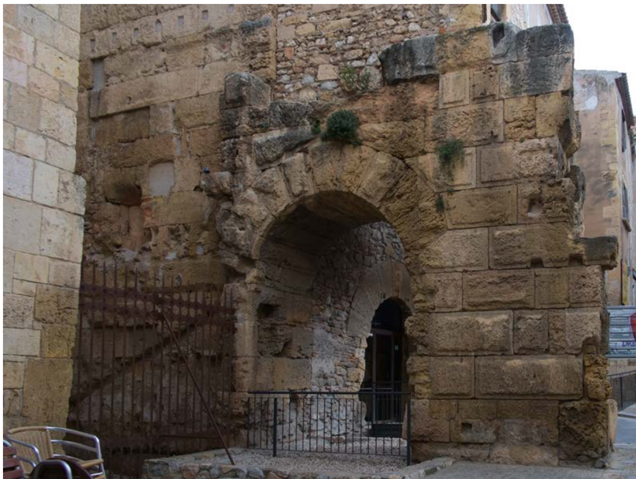
Fig. 110b: Arco romano de medio punto construido en sillería almohadillada que se ha conservado en la Plaza del Pallol. Actualmente aparece integrado en la construcción medieval y moderna del Beaterio de Sant Domènech. En época romana, esta puerta constituía un acceso a los criptopórticos abovedados desde el exterior del conjunto provincial.
