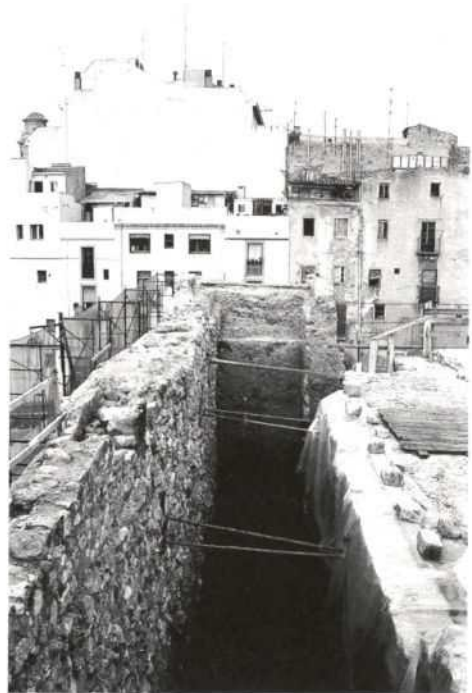
Detall de la torre de les Monges, a la capçalera oriental del circ, i de la secció de la Muralleta abans de les excavacions arqueològiques de 1993
