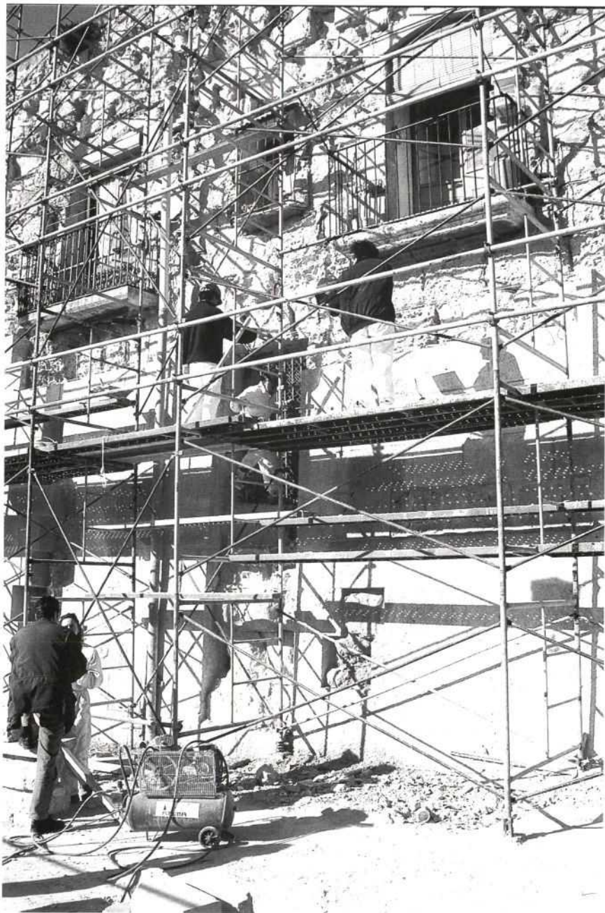
Detall dels treballs del Taller-Escola de Restauració de la Muralla (TERM) a la zona del portal de Sant Antoni
