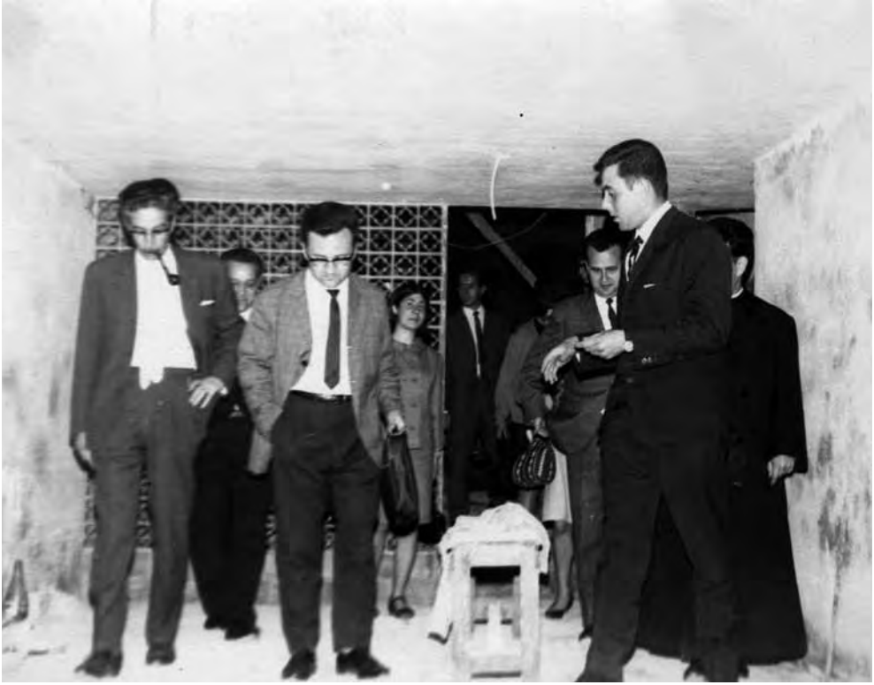
Enric Olivé i Pere Fort visiten les obres del local social.
