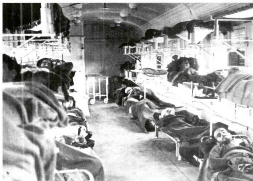
Interior d'un tren hospital durant la batalla de l'Ebre. Els trens estaven estacionats en el túnel de l'Argentera i l'estació dels Guiamets.
