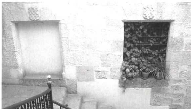
Antiga casa de la ciutat. Porta tapiada a mitja escala d'accés a la planta noble, per on s'entrava a la taula des de l'interior de l'edifici.
