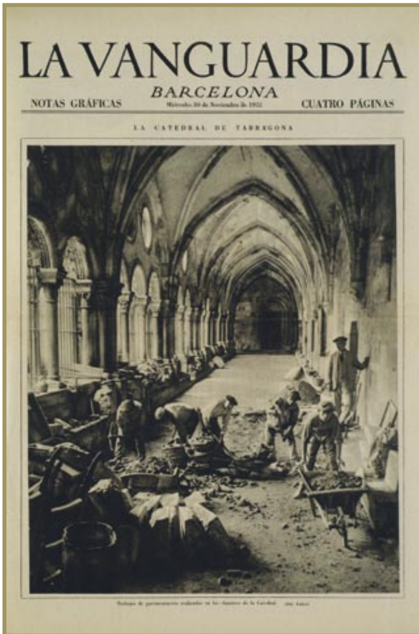
Treballs de pavimentació al claustre de la Catedral. Foto: Vallvé. Publicada a La Vanguardia , 30 de novembre de 1932. BHMT.
