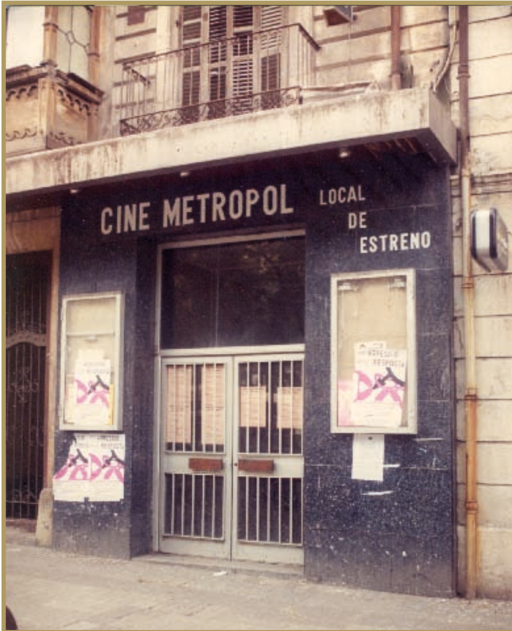
Façana del cinema Metropol. Autor: Foto Chinchilla. 1990. AHCT. Reg. 34810.
