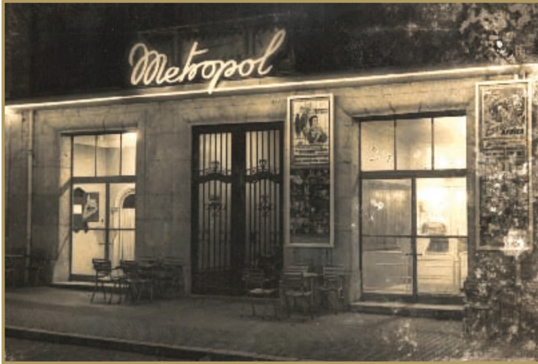
Façana del Cinema Metropol. Any 1961. Fons Vallvé. AHCT
