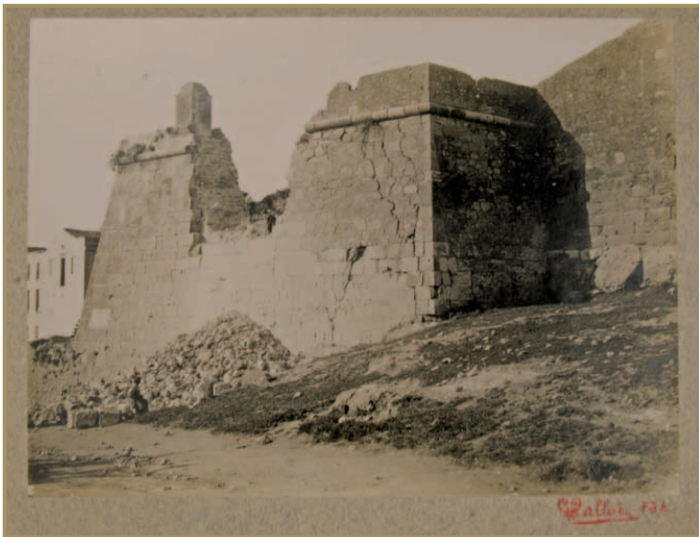
Imatge en la qual s'observa l'estat del baluard de Sant Antoni després de la demolició del 1813, fotografia d'inicis del segle XX. (Fons Vallvé/AHCT).
