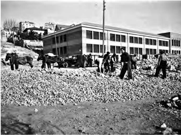
▲ Treballs d'excavacions a la zona de l'Amfiteatre, abril de 1937.
