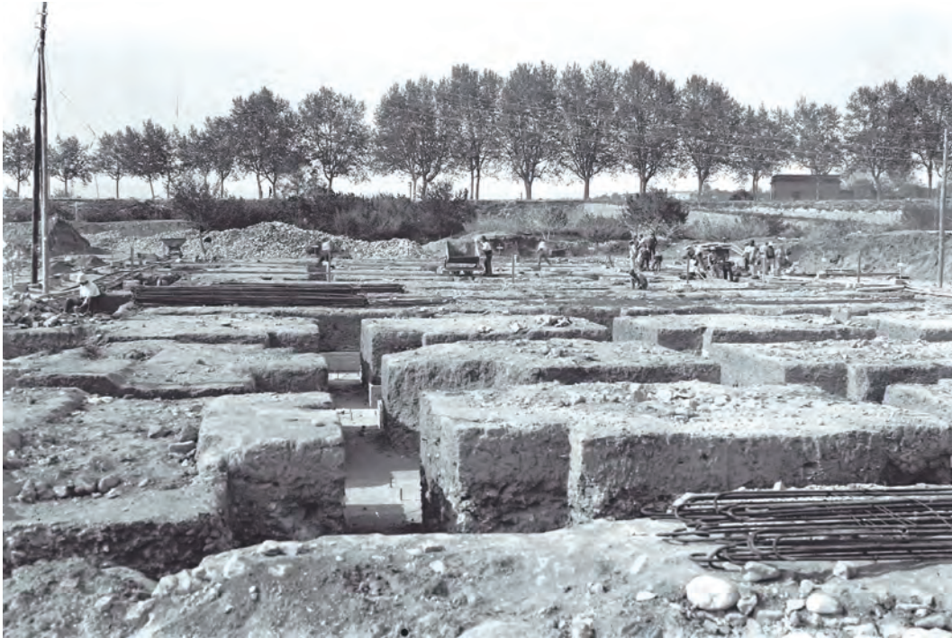
▲ Fonaments de la Fàbrica de Tabacs a la segona meitat dels anys vint. Al fons, el passeig de la Independència. (P. Pallejà)
