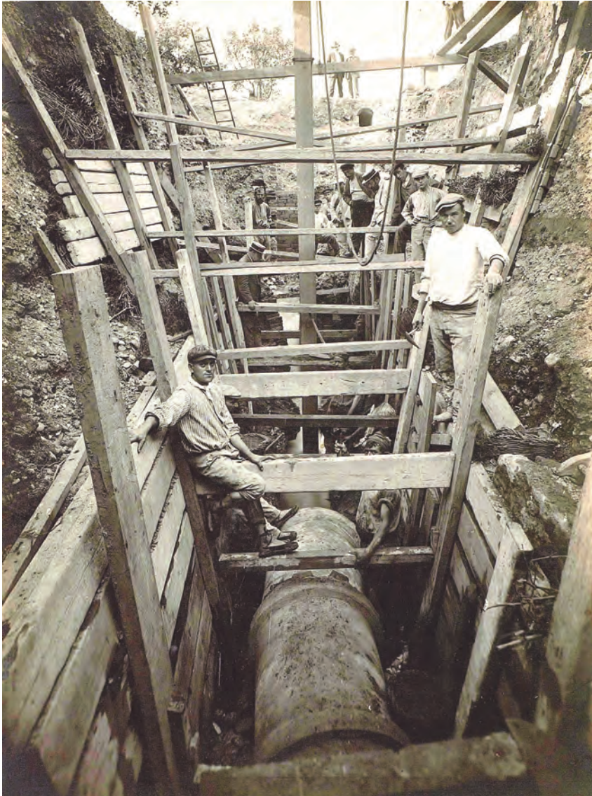
◀ Obres per a la canalització de l'aigua, any 1910. (P. Pallejà) ▶
