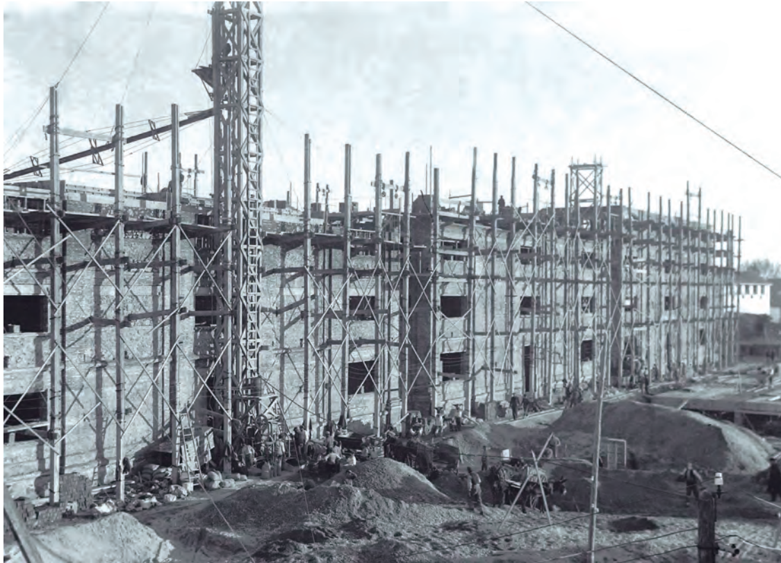
▲ Bastides i obrers durant la construcció dels magatzems de la Fàbrica de Tabacs als anys vint. (P. Pallejà)
