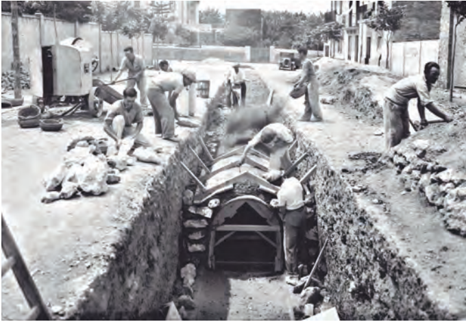
▲ Obriers treballant en el soterrament del clavegueram en els carrers de la ciutat, any 1934. Foto Vallvé. CIT / L'Arxiu
