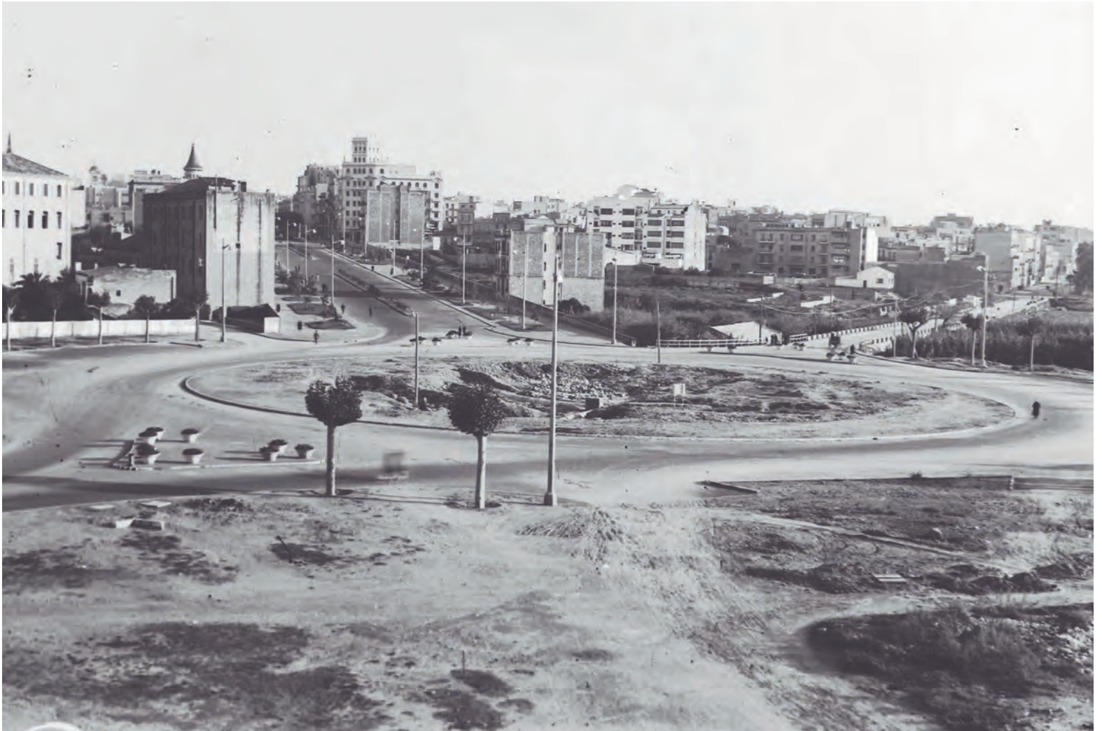
▲ Obres d'urbanització de la Plaça Imperial Tàrraco a mitjans dels anys cinquanta, seguint les directrius del Pla d'Eixample de l'any 1922. Foto Chinchilla. CIT / L'Arxiu
