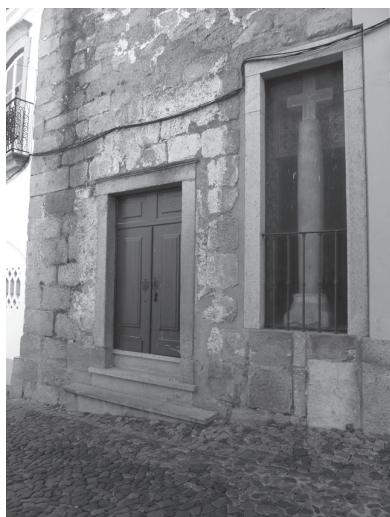
Capilla de São Manços, en la cerca velha .
