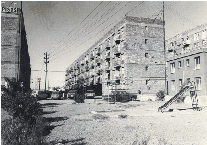
Línia elèctrica d'alta tensió que passa entre blocs i és en un descampat amb modestos jocs per a la canalla. El carrer que hi ha entre els dos és el que es coneix al barri com a «Rambla de la Floresta». Any: 1975 (Foto cedida per l'Associació de Veïns de la Floresta).
