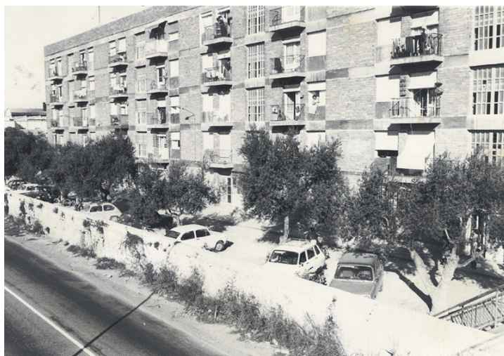
L'edifici Abeto, el primer de la urbanització, està separat de la carretera per un mur (Foto cedida per l'Associació de Veïns de la Floresta).
