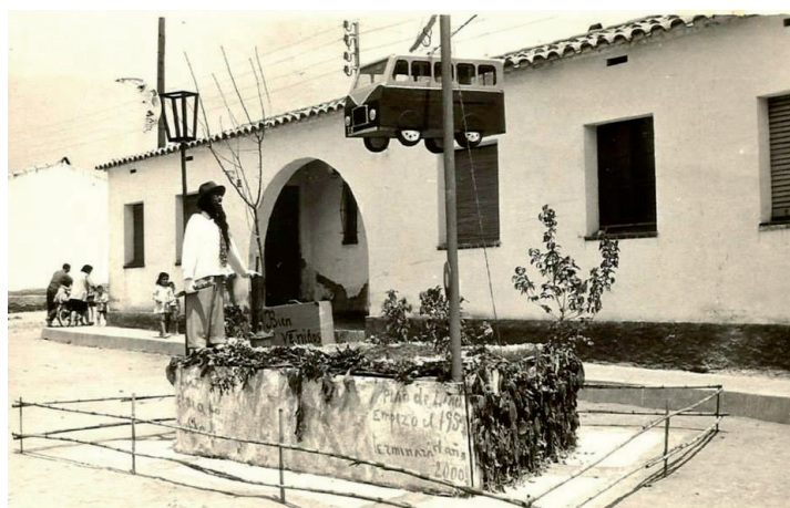
Una falla en una de les cases baixes de Torreforta a principis de la dècada dels seixanta, es reclama una solució per als principals problemes del barri: aigua, llum i transport. (Arxiu: Rafael Vidal Ragazzon).
