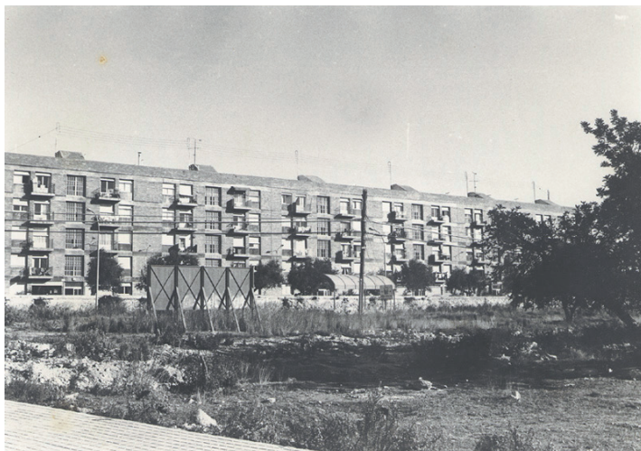
El primer edifici construït a la Floresta, a tocar de la carretera de Reus. (Foto cedida per l'Associació de Veïns de la Floresta i recopilada per Tecla Martorell al CD Els nuclis de ponent. La Floresta, L'Albada, Parc Riuar. Edita: Museu d'Història de Tarragona, 2005).
