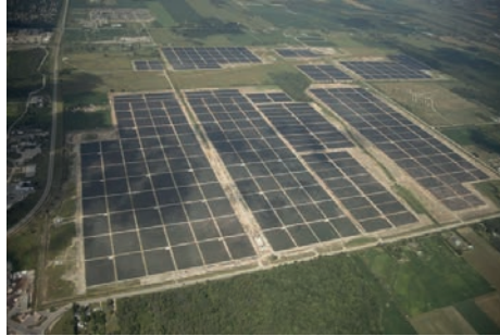
Figura 19. Energia solar fotovoltaica. La central fotovoltaica més gran del món
