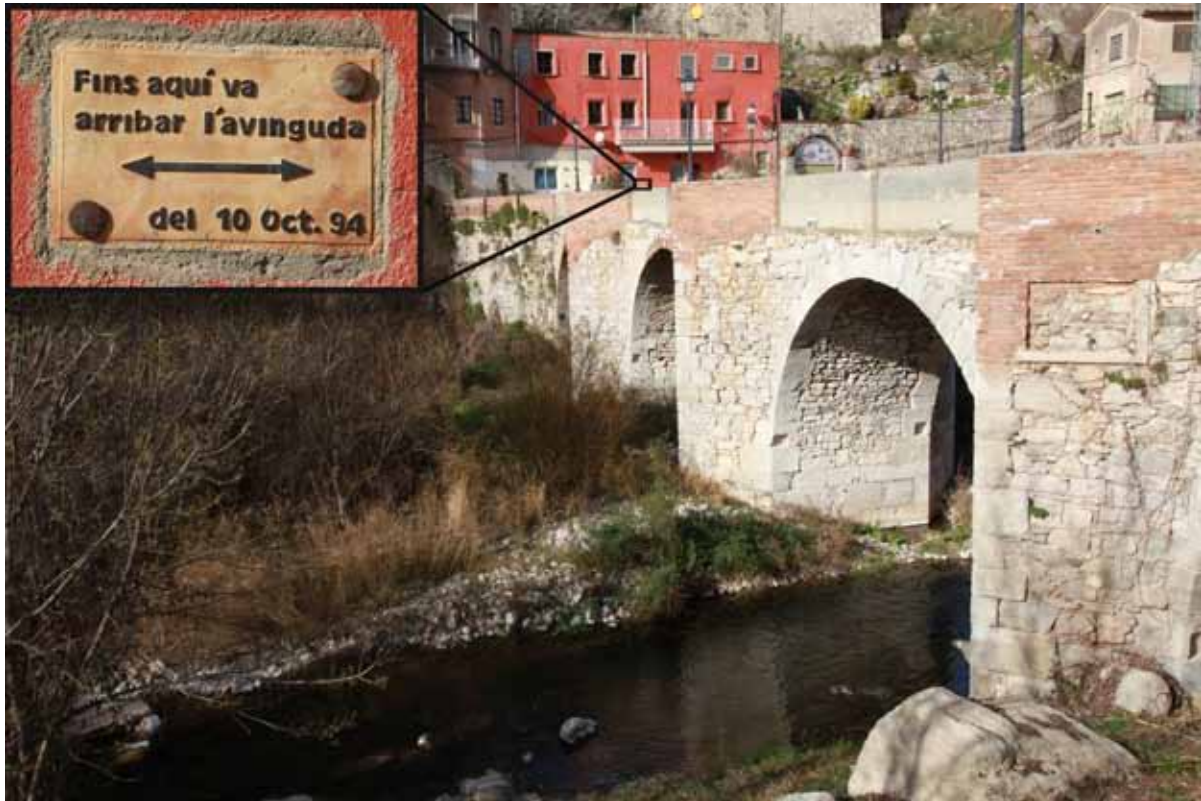
Figura 2.2.27. Testimoni del nivell que va assolir l'aigua durant l'aiguat del 10 d'octubre de 1994 al pont de Cal Cisquet de la Riba, situat gairebé a 10 metres per sobre del llit del riu Francolí.
