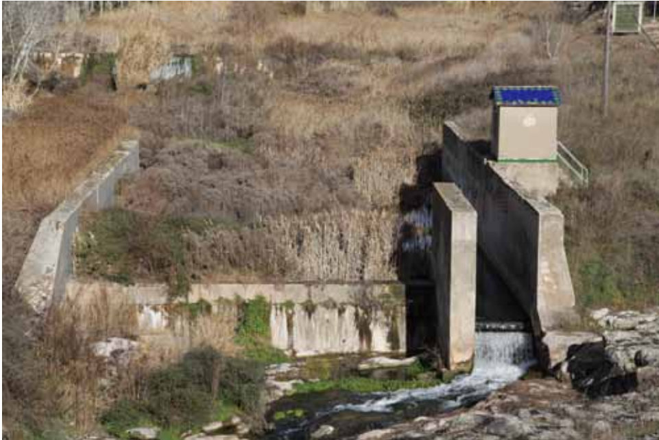
Figura 2.6.5. Estació d'aforament de l'Agència Catalana de l'Aigua al riu Francolí a la zona de la Sallida (Montblanc).
