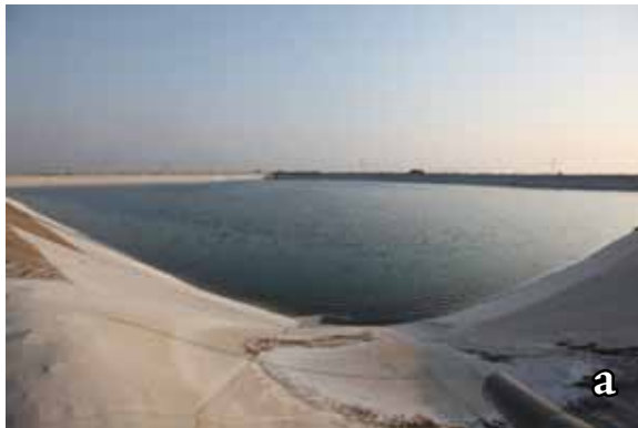
Figura 2.6.44. Bassa de La Montoliva, a Vilallonga del Camp (a); punt d'aigua de les Garrigues, a Vilaverd (b), i bassa de prevenció d'abocaments del complex petroquímic de Repsol, a la Pobla de Mafumet (c).
