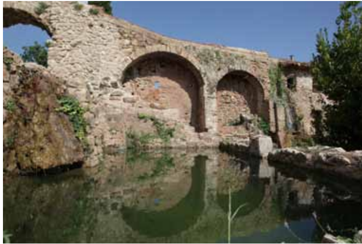
Figura 3.2.4. Canal d'aigua del riu Glorieta que, antigament, era utilitzat per generar energia mecànica per fer moure la maquinària dels molins de Tarrés (Alcover).
