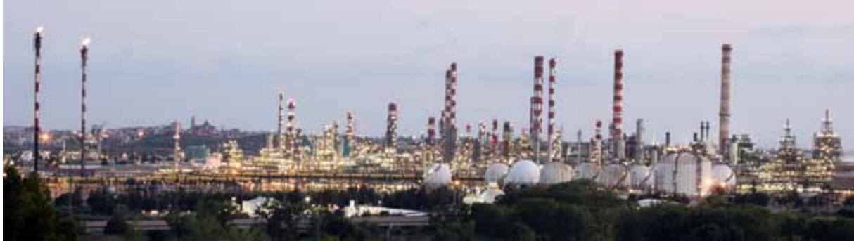
Figura 2.5.26. Refineria de Repsol a la Pobla de Mafumet.
