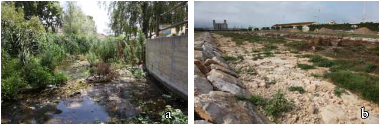
Figura 3.2.11. Murs de contenció al Parc Fluvial de l'Espluga de Francolí (a) i canalització del Francolí a Tarragona (b).
