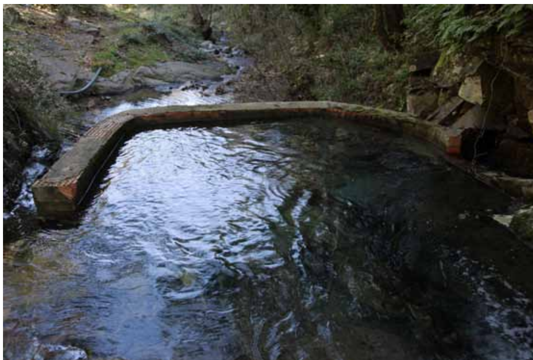
Figura 3.2.3. Petita resclosa construïda al barranc del Tillar per subministrar aigua de xarxa al municipi de Vimbodí i Poblet.
