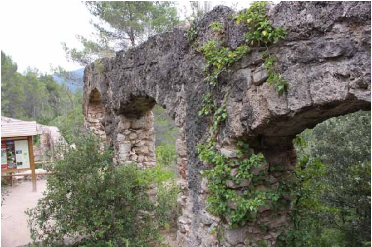
Figura 2.6.43. Canal per conduir l'aigua a la Centralita del Glorieta (Mont-ral).
