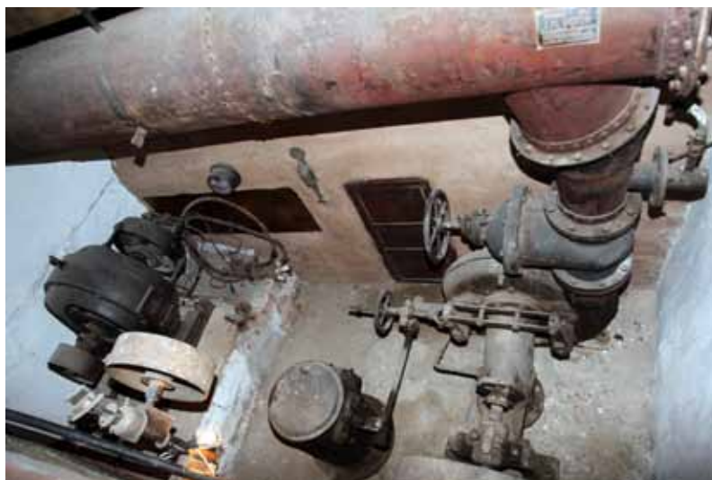
Figura 3.1.7. Turbina restaurada de la central hidroelèctrica del Molí d'en Fort, al riu Brugent (Farena, Mont-ral).
