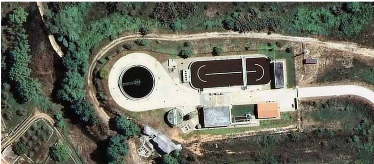
Figura 2.6.51. Vista aèria de l'estació depuradora d'aigües residuals de l'Espluga de Francolí.
