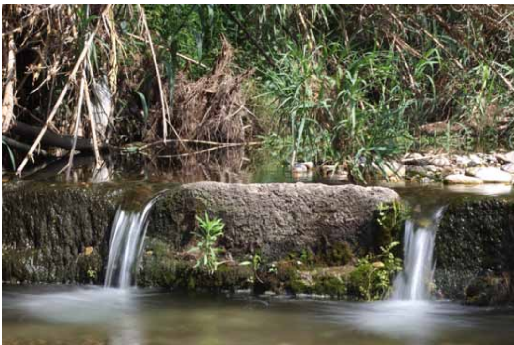
Figura 3.2.8. Petita resclosa amb una captació d'aigua al torrent del Catllar a Valls.
