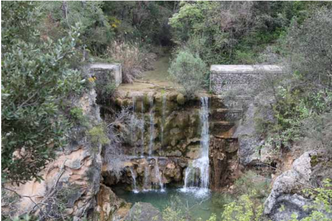
Figura 3.2.9. Resclosa saturada de sediments al riu Brugent riu avall de les Tosques, a Capafonts.
