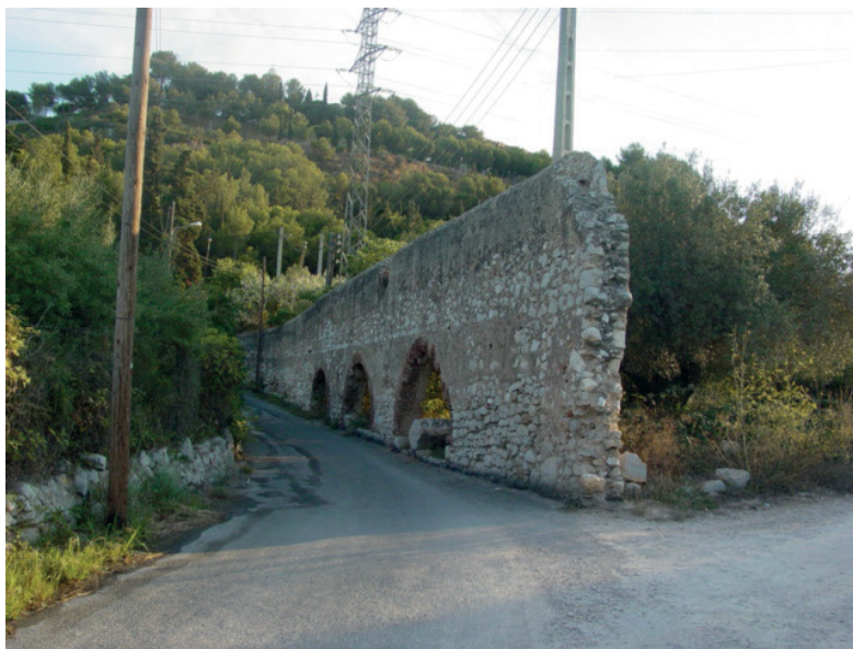
Figura 53. Aqüeducte de les Morisques (Tarragona).
