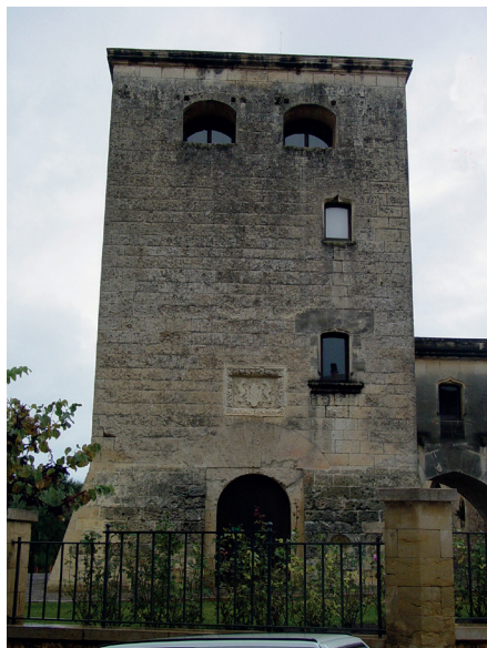
Figura 50. Torre Vella de Salou (Tarragonès).
