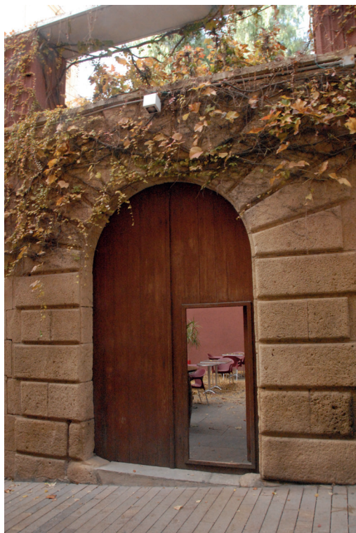
Figura 55. Portalada serliana del carrer Sant Llorenç, casa de l'arquitecte Pere Blai i ara seu del Col·legi d'Arquitectes (Tarragona).
