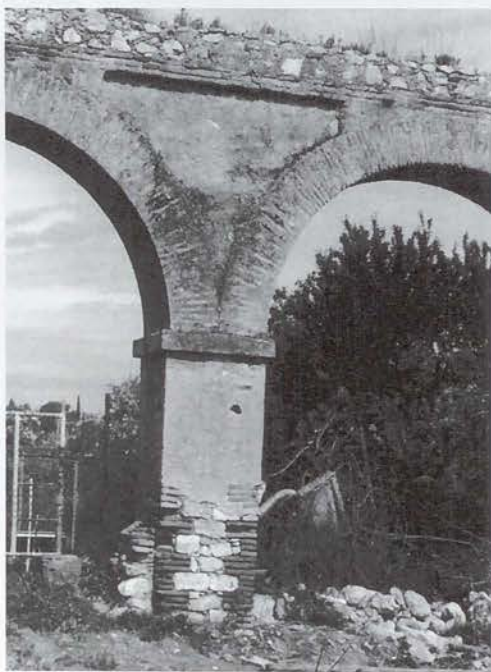
Aqüeducte que conduïa l'aigua de la font del Llorito a Tarragona (1610-1625). Arcades construïdes per salvar el desnivell del torrent de Canyelles o de l'Arrabassada.
