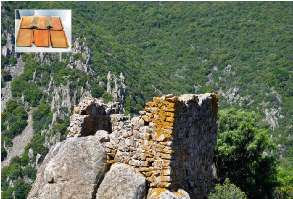
Torre del Moro de Castellfollit (Vimbodí i Poblet). La torre estava coberta amb teules romanes. Foto: A. Carreras, 1984.
