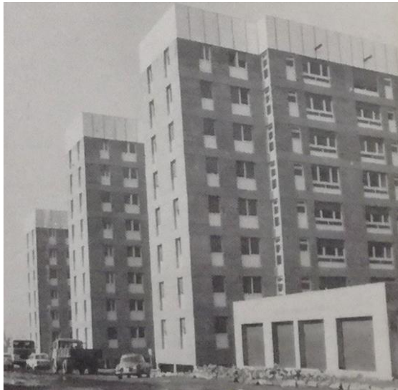
Figura 1. Conjunt de blocs de pisos on residien treballadors de SEAT. Font: SEAT. Revista de Empresa , 22, 12/1966, 39.
