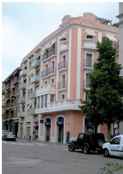
Edifici del carrer Sant Ot, nº 2. Ocupa el lloc on hi havia hagut la fonda Cal Bartolo (Fotografia de Carme Oriol Carazo).
