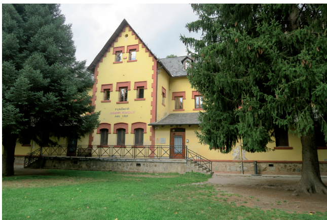
Edifici Joaquim Morelló (Fotografia de Carme Oriol Carazo).
